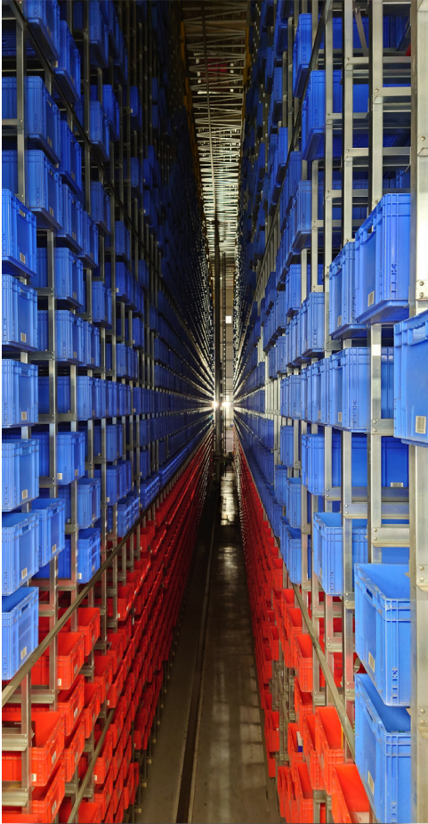
Hochregallager mit doppelten Lagerplätzen wird mit Delphi Programmen optimiert angesteuert
